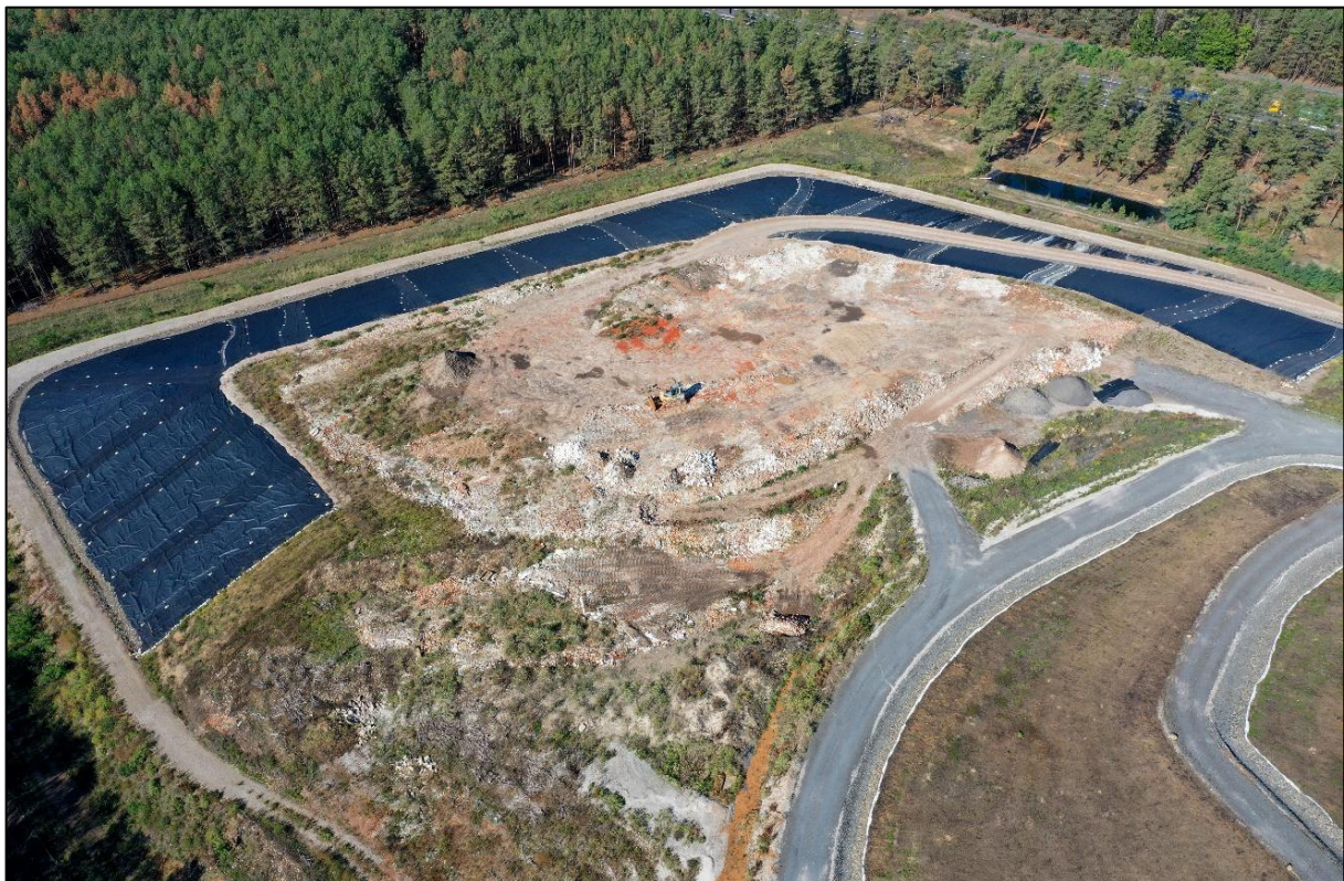
Abbildung 26: Schüttbereich II der Deponie Forst-Autobahn
