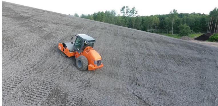
Abbildung 7: Herstellung der Trag- und Ausgleichsschicht auf der Deponie Forst-Autobahn 2017
