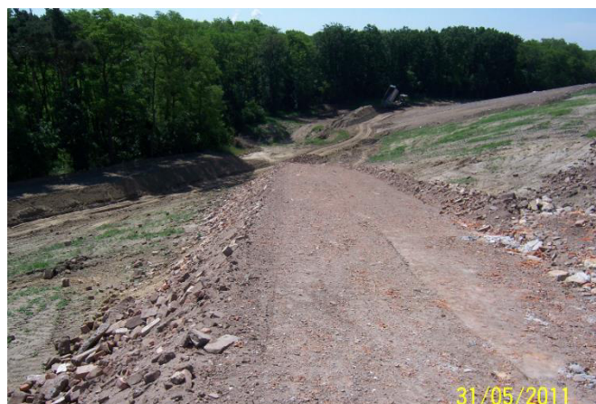
Abbildung 5: Bau Auffahrt mit Gemischen aus Beton, Ziegel, Fliesen und Keramik auf der Deponie Spremberg-Cantdorf
