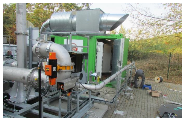
September 2018: Zusammenbau der Einzelkomponenten der Regenerativen Thermischen Oxydationsanlage (RTO) bei der Firma BMF Haase Energietechnik
