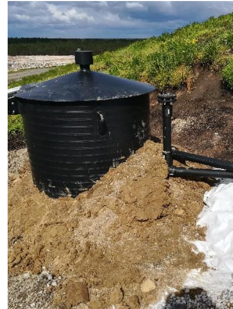
März 2021: Leitungsverlegung, Umrüstung und Anschluss der Deponiegasbrunnen auf dem Schüttbereich I der Deponie Forst-Autobahn
