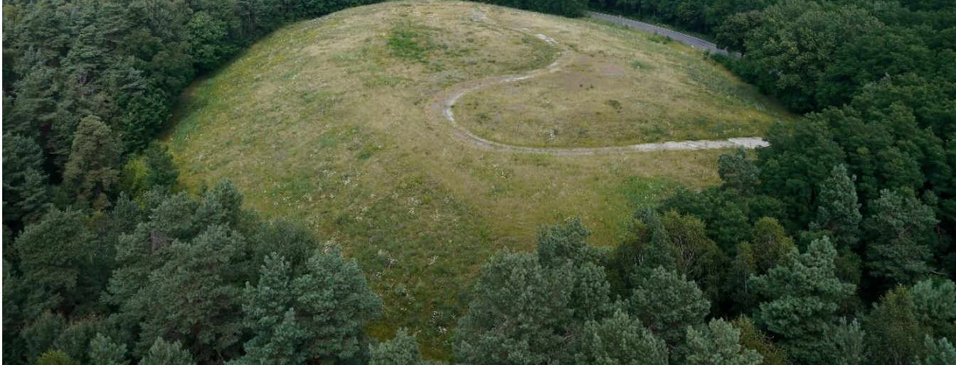
Mai 2007: Fertigstellung der Oberflächenabdeckung
