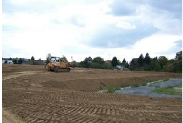
September 2007: Einbau der 1,5 bis 2,5 m mächtigen Wasserhaushaltsschicht
