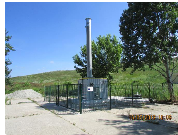
Juli 2013 Beginn des Absaugbetriebes mit einer Schwachgasfackel
