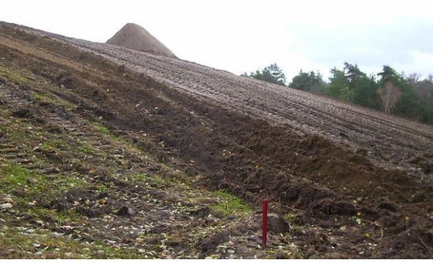
Februar/April 2007: Bau der Oberflächenabdeckung mit 1 m Wasserhaushaltsschicht
