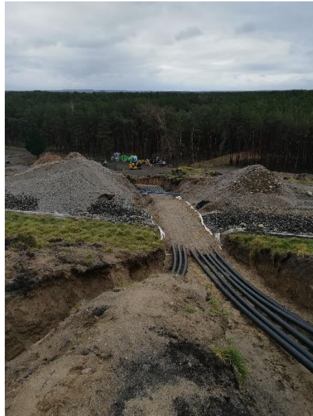
März 2021: Leitungsverlegung, Umrüstung und Anschluss der Deponiegasbrunnen auf dem Schüttbereich I der Deponie Forst-Autobahn
