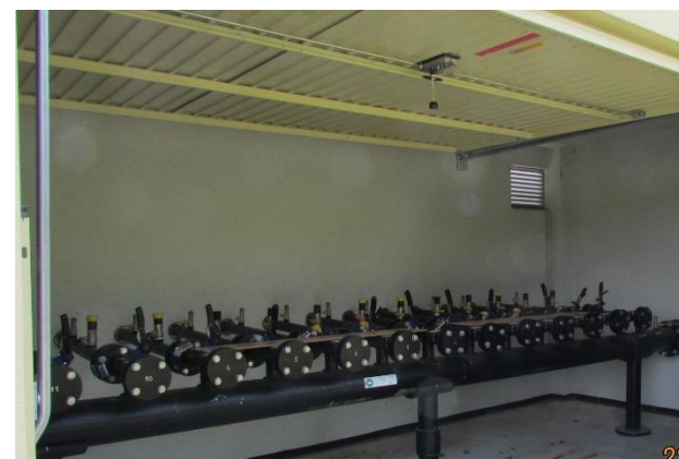
2013: Errichtung der Gassammelstation für 13 Deponiegasbrunnen
