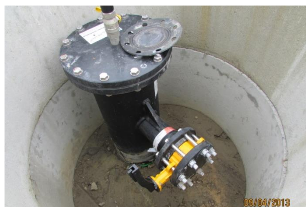
November 2018: Umbau der Gasbrunnen für den Übersaugungsbetrieb
