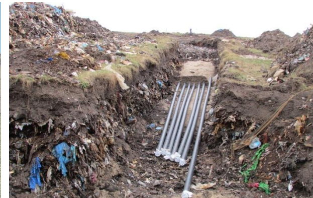
2012: Verlegung der Gassammelleitungen in den Deponiekörper
