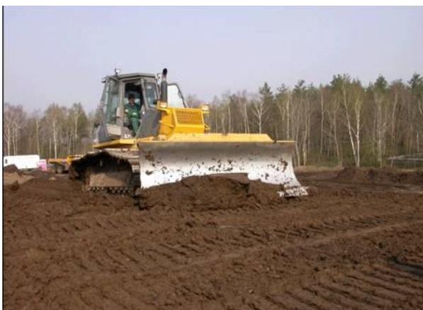
Oktober 2004 bis März 2005: Einbau unteren Wasserhaushaltsschicht 1,2 m
