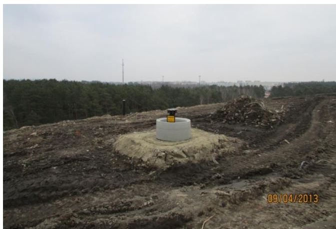
2013: Ausbau und Sicherung der Deponiegasbrunnen
