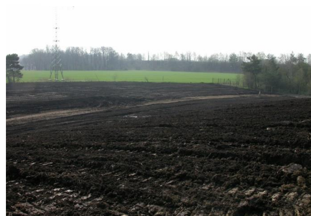
März 2005: Einbau der oberen Wasserhaushaltssicht (Waldboden)
