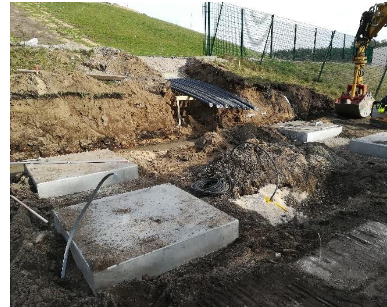
März 2021: Leitungsverlegung, Umrüstung und Anschluss der Deponiegasbrunnen auf dem Schüttbereich I der Deponie Forst-Autobahn
