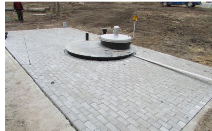
2012/2013 Bau des Kondensatsammelschachtes
