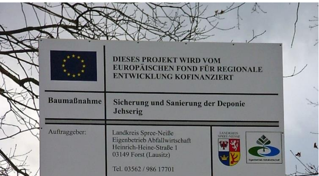
Februar 2007: Beginn der Sicherungsmaßnahme
