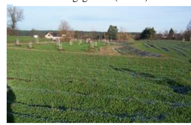
Oktober 2007: Bau des Rand- und des Bewirtschaftungsweges (830 m)
