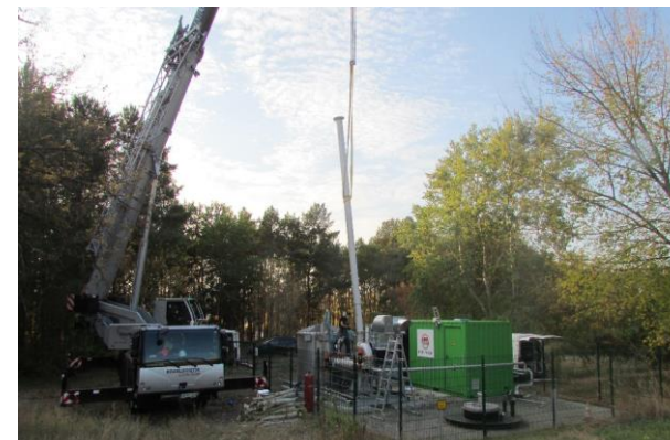
Oktober 2018: Anlieferung und Aufbau der RTO auf dem Deponiegelände
