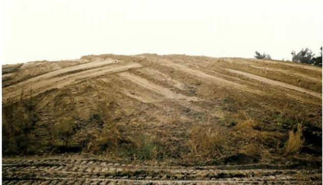
1997: Profilierung, und Zwischenabdeckung mit ca. 30 cm Boden
