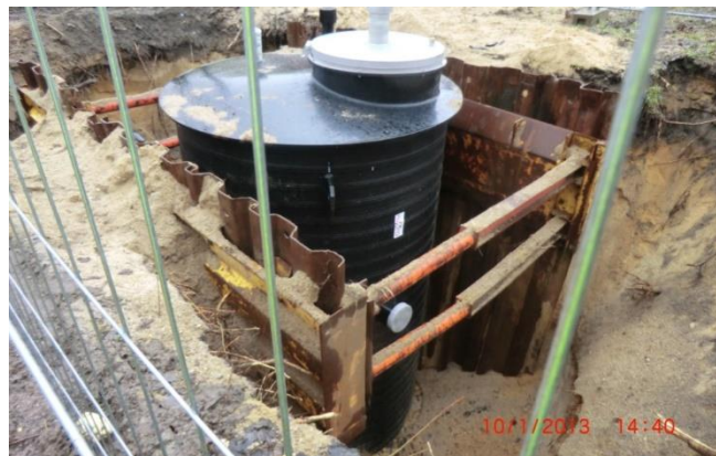
2012/2013 Bau des Kondensatsammelschachtes
