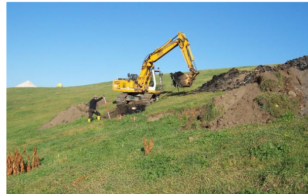
2012: Verlegung der Gassammelleitungen in den Deponiekörper
