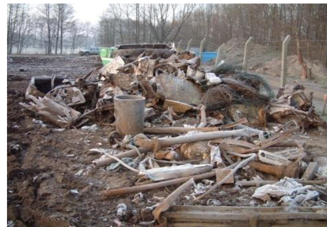
Bergung von Schrott, Holz und gefährlichen Abfällen (620 Mg)
