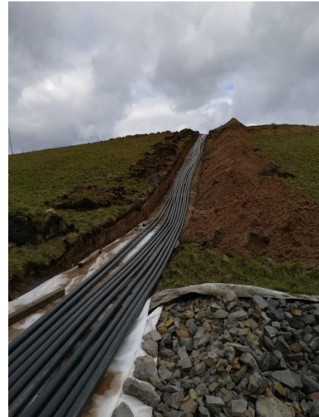
März 2021: Leitungsverlegung, Umrüstung und Anschluss der Deponiegasbrunnen auf dem Schüttbereich I der Deponie Forst-Autobahn
