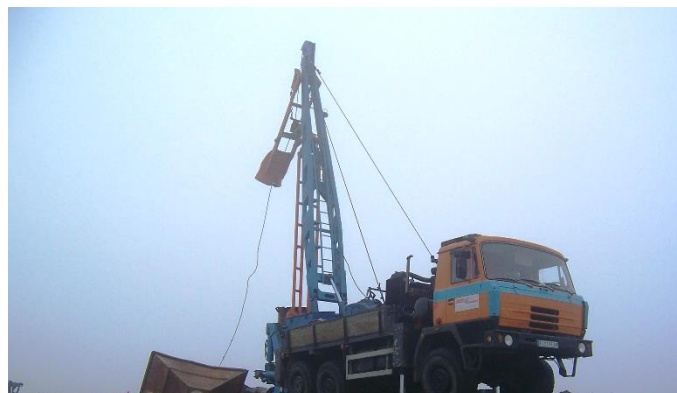
2012: Bohrung der neuen Gasbrunnen
