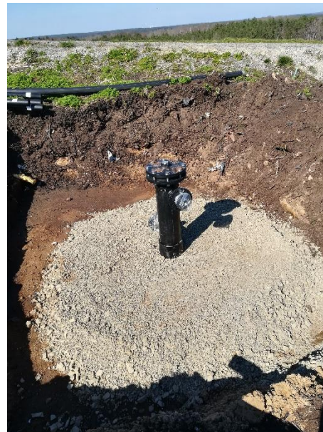
März 2021: Leitungsverlegung, Umrüstung und Anschluss der Deponiegasbrunnen auf dem Schüttbereich I der Deponie Forst-Autobahn
