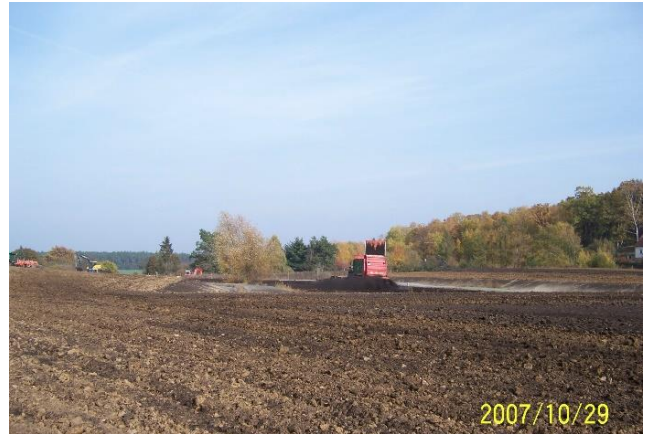
Oktober 2008: Einfräsen von Kompost zur Herstellung der oberen Wasserhaushaltsschicht (0,3 m)
