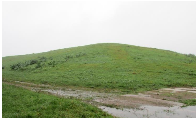
Istzustand 2011 nach dem Aufbringen der Zwischenabdeckung ohne Gasfassung
