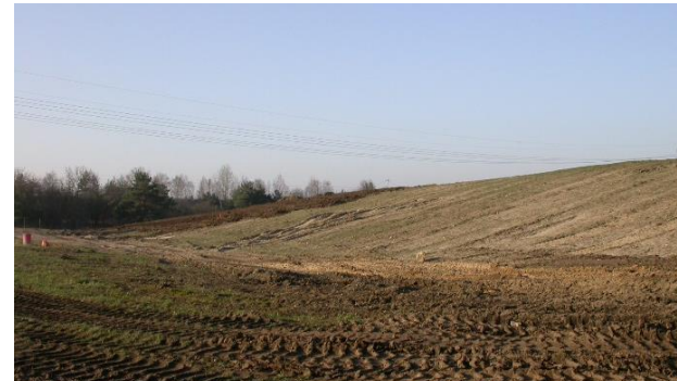
Oktober 2004: Abfallumlagerung und Profilierung des Deponiekörpers
