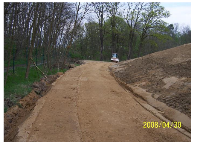
April/Mai 2007: Herstellung der Oberflächenentwässerung sowie des Ringweges
