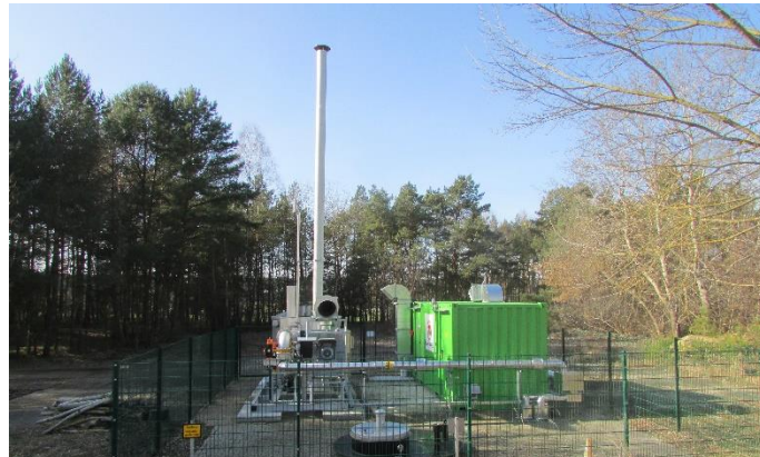
November/Dezember 2018: Aufnahme des Probetriebes und Abnahme der Anlage
