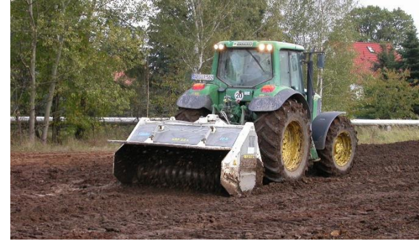
Oktober 2004: Bau des Versuchsfeldes der Wasserhaushaltsschicht
