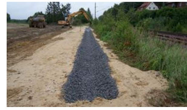
Juni 2007: Bau der Oberflächen- entwässerungsgräben (740 m)
