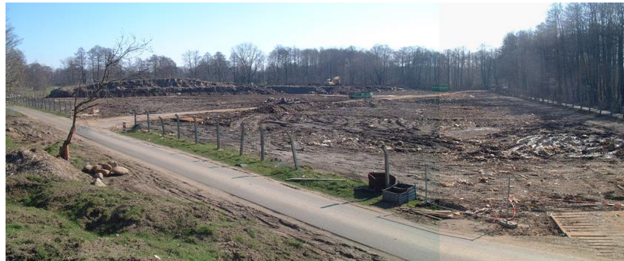
Februar 2005: Rückbau von ca. 90 % der Deponiefläche
