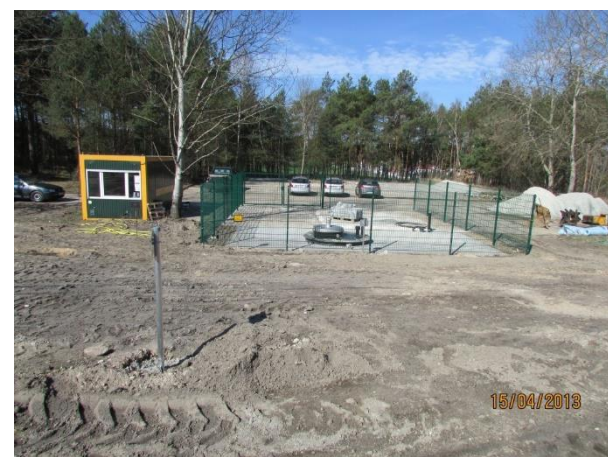
2013: Bau der Aufstandsfläche für die Verdichter- und Fackelanlage
