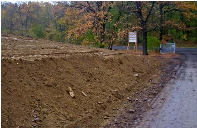
Mai 2007: Fertigstellung der Oberflächenabdeckung
