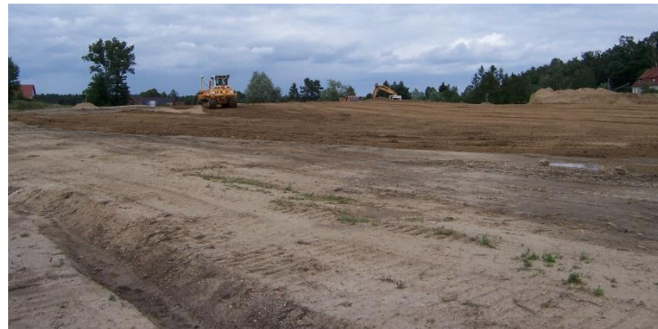
Juni 2007 Beginn der Profilierungsarbeiten
