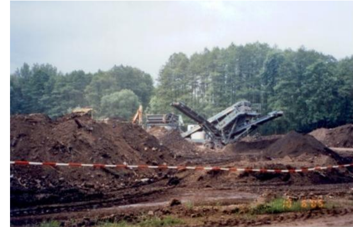
tiefgründige Siebung des Untergrundes bis zum Grundwasser (5.600 Mg Sortierreste)
